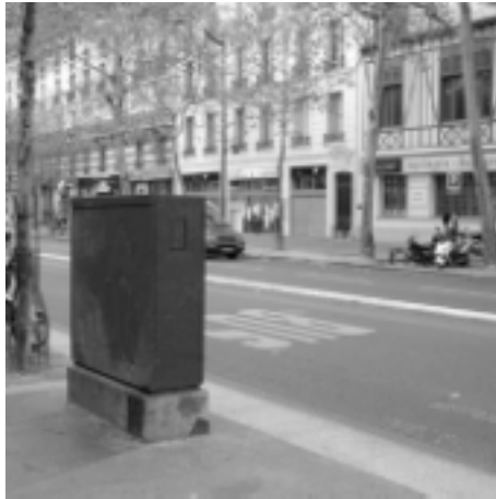
Photo 5. Armoire de carrefour ou séparateur de voie bus-vélos ? Quel préjudice esthétique ?
